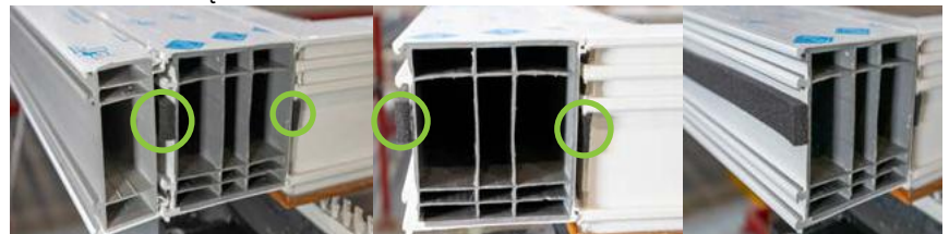
TAŚMA ROZPRĘŻNA DO POSZERZEŃ MONTOWANYCH NA PRODUKCJI
